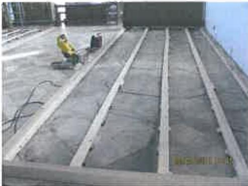
Unterbau des Laiengestühls mit neuer Verkabelung der Heizung
