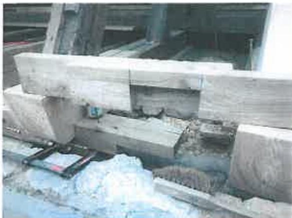
Neue Mauerschwellen aus Eichenholz mussten aufwendig eingebaut werden
