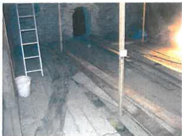
Alter Bodenbelag und belastete Isolierung im Dachboden des Langhauses
