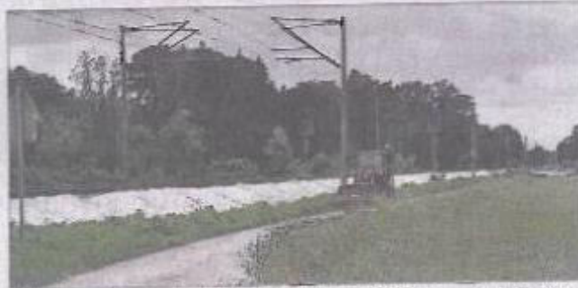
Bahndamm in Unterreit: ein Brennpunkt beim Hochwasser.
