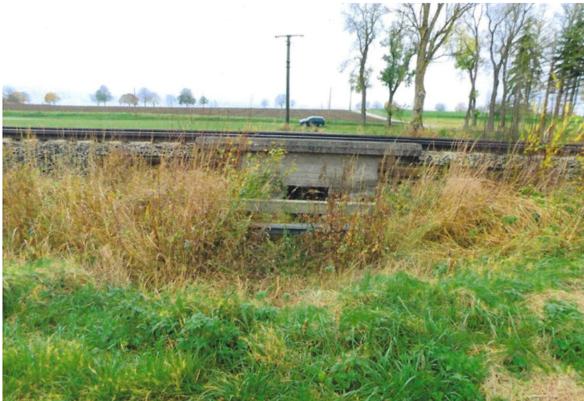
Durchlass bei km 53,809 in Moosham, Foto aufgenommen im Jahr 2019. Im Hintergrund die Stromasten der Stadtwerke München, die inzwischen durch Erdkabel ersetzt wurden.
