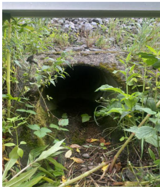
Ein weiterer Durchlass befindet sich gegenüber des Spiel- & Fußballplatzes Thonstetten bei km 54/1.
